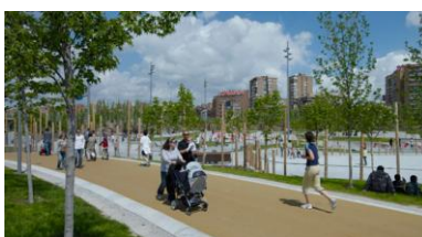
Pavimento blando. Tierra compactada
